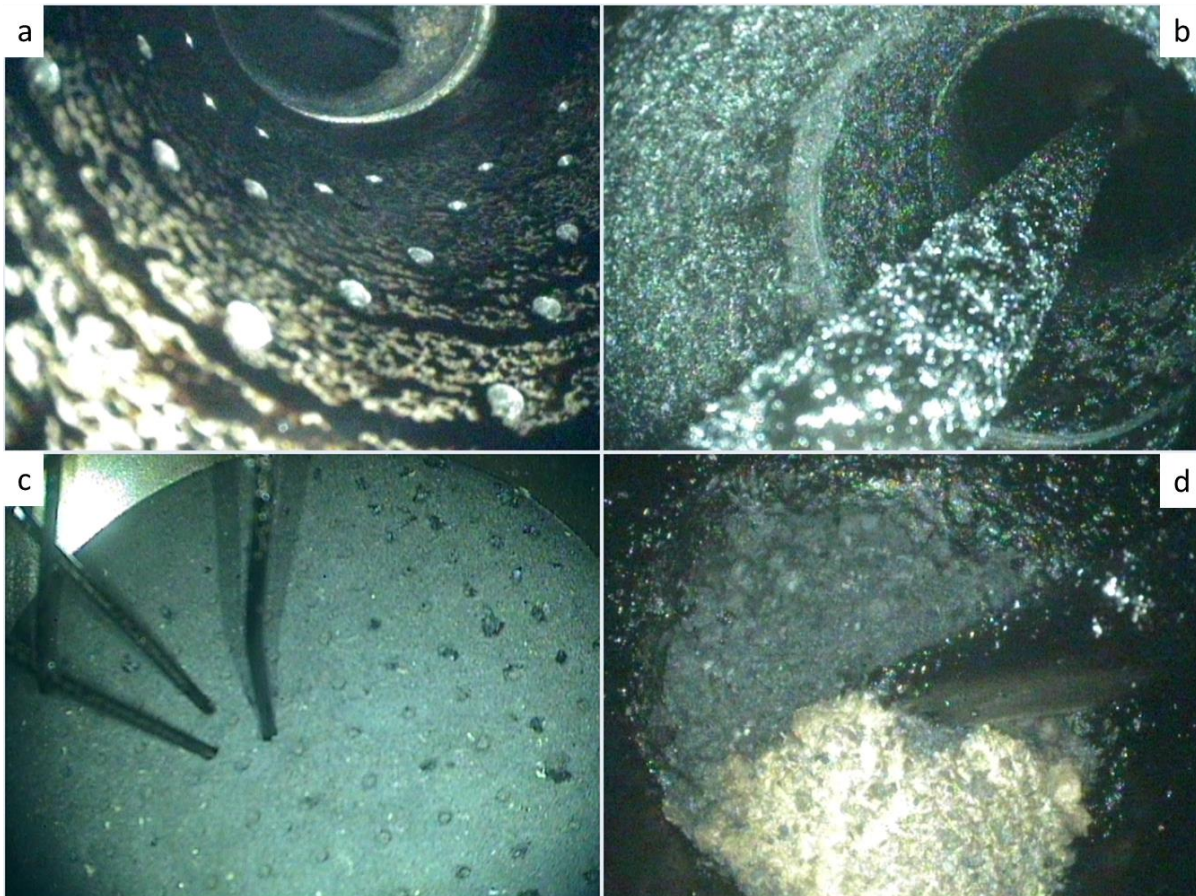
Abbildung 21: Innenansicht des Porenbrenners und Vergasers nach den ersten Kombinationsexperimenten: a) Mischkammer: Löcher für Erdgas und Sekundärluftzufuhr sind frei. Leichte Teerablagerungen an den Wänden. b) Oberer Teil des Vergasers mit Schutzrohr für Thermoelemente mit größeren Anbackungen. c) Flammensperre mit Thermoelementen: Teerablagerungen an den Thermoelementen und an der Flammensperre. d) Unterer Teil des Vergasers mit Restkoks und starken Teerablagerungen in der Reaktionszone.
