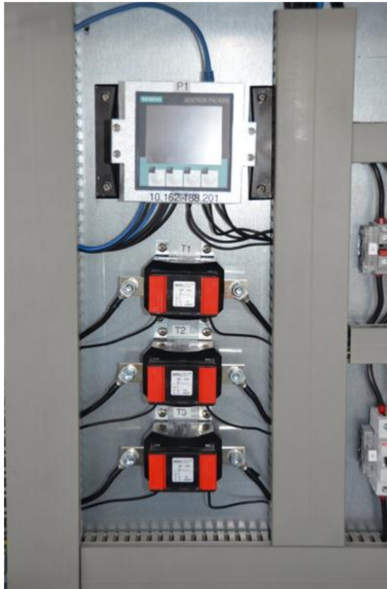
Abbildung 8: Messanordnung bestehend aus Sentron PAC 4200 (oben) und Stromwandlern (unten)
